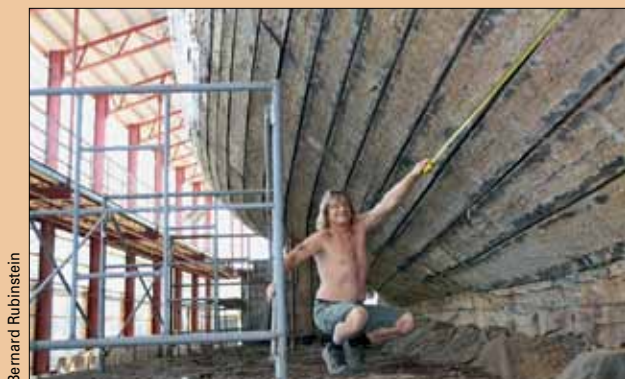
Le Néo-Zélandais Cris Morrison est le patron de cet immense chantier.
