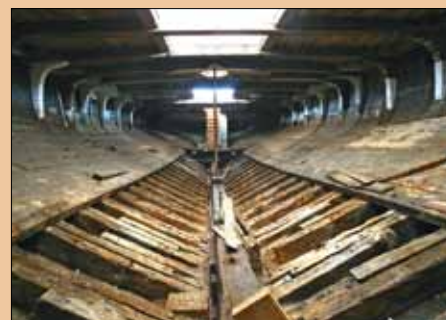
Tous les aménagements du bateau ont été démontés avant de débiter la restauration.
