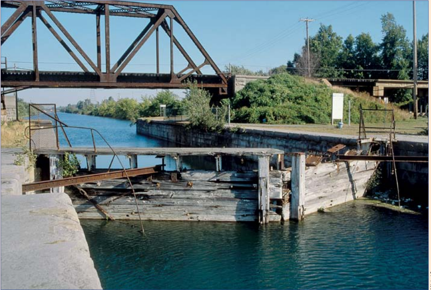
Les portes des cinq écluses du canal sont en bien mauvais état. D'importants travaux seraient nécessaires pour remettre le canal en service.
