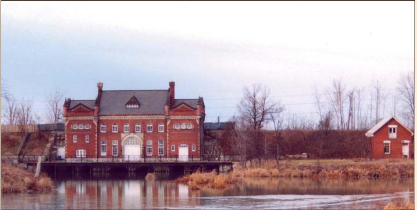
La centrale hydroélectrique du canal de Soulanges, classée monument historique en 1984. 103-02 Fonds Canal de Soulanges © Centre d'histoire La Presqu'île
