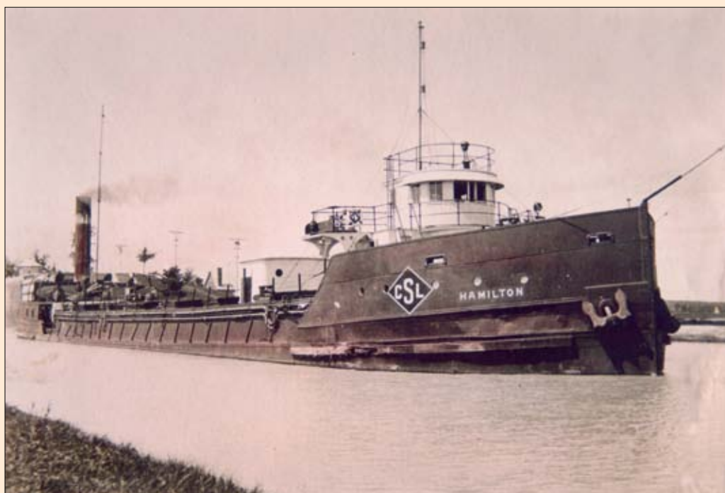
Le canalisier Hamilton de la Canadian Steamship Line à sa sortie de l'écluse numéro 2. Vers 1950. Notez la perche sur l'étrave qui servait de repère directionnel au timonier pour s'engager dans les écluses. P20-64 Fonds Pierre Clément © Centre d'histoire La Presqu'île
