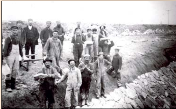
Travailleurs procédant à l'enrochement des berges du canal de Soulanges afin d'éviter de nouveaux éboulis. Vers 1897. P20-215 Fonds Pierre Clément © Centre d'histoire La Presqu'île
