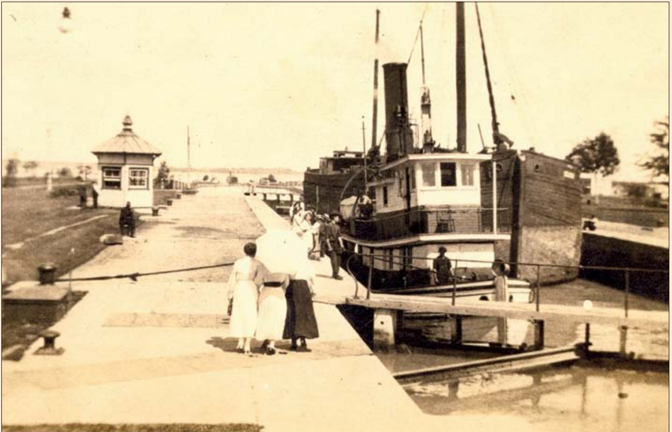
Un remorqueur tirant une barge à l'écluse numéro 1 à Pointe-des-Cascades. Premier quart du XX e siècle. Les premiers navires à traverser le canal de Soulanges seront bien souvent des barges tirées par des remorqueurs.
